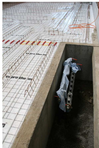
Die Erdwärmesonden wurden in das Hallenfundament integriert
