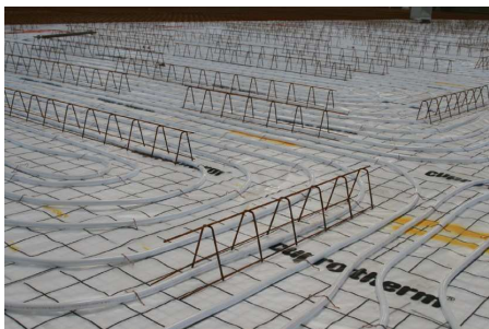
Die verlegten Rohre, ergänzt durch die Aufständeringe
