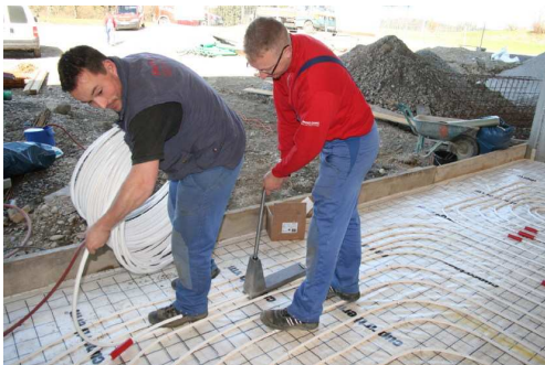
Insgesamt wurden rund 17.000 Rohrmeter verlegt (links) – Rohrverlegung und Stahlbau erfolgten abschnittsweise nacheinander (rechts)
