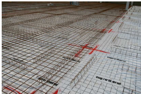
Insgesamt wurden rund 17.000 Rohrmeter verlegt (links) – Rohrverlegung und Stahlbau erfolgten abschnittsweise nacheinander (rechts)
