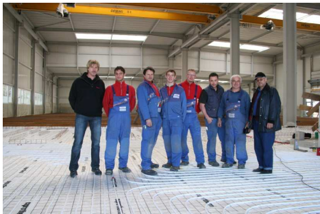
Die verlegten Rohre, ergänzt durch die Aufständeringe
